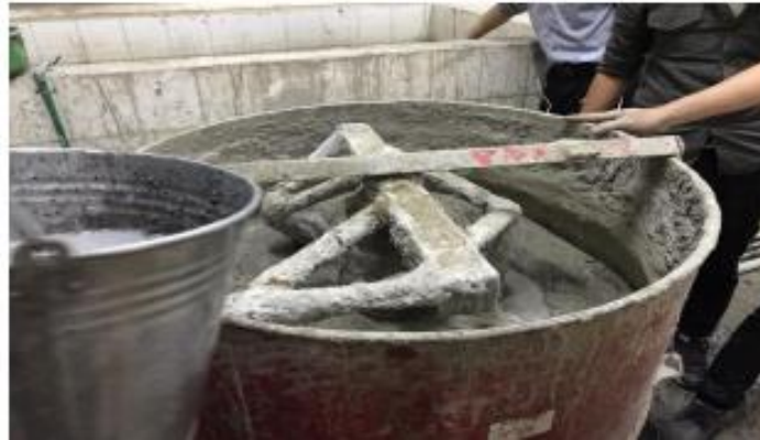
Hình 2: Nhào trộn hỗn hợp bê tông nhẹ bằng máy
